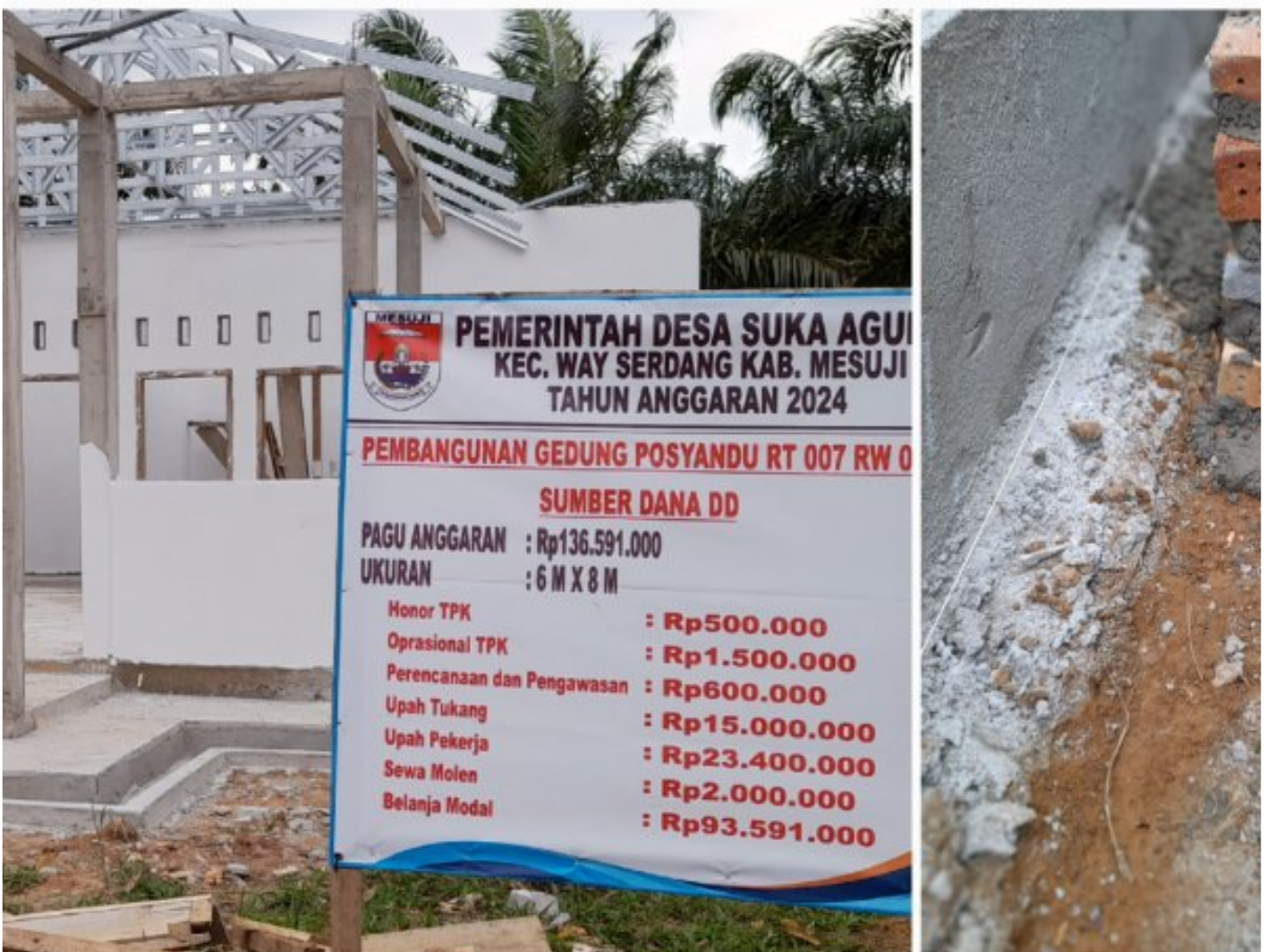
Pembangunan Posyandu Suka Agung Way Serdang
